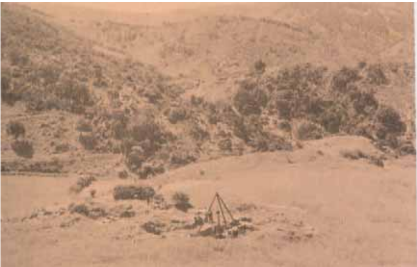
Fig 14. Antas. Il tempio durante i lavori preliminari
