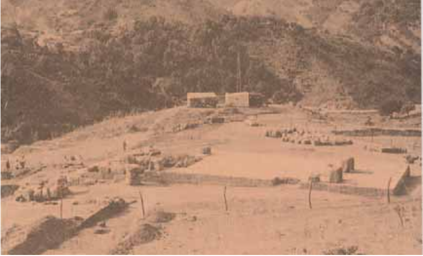
Fig. 20. Antas. Il tempio romano visto da Nord durante i lavori di scavo e restauro.
